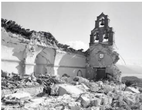
Разрушенная землетрясением церковь в Черногории в 1997 году
