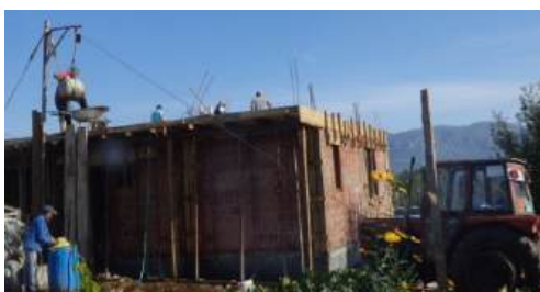
Начало строительства возле моего дома
